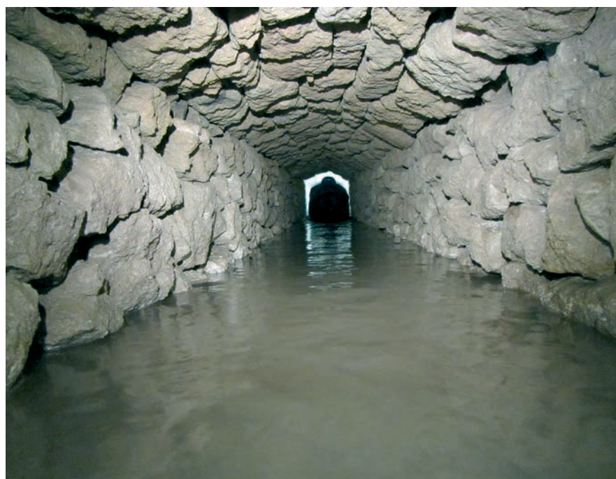
Galerie réseau 2. Cliché ASSE
