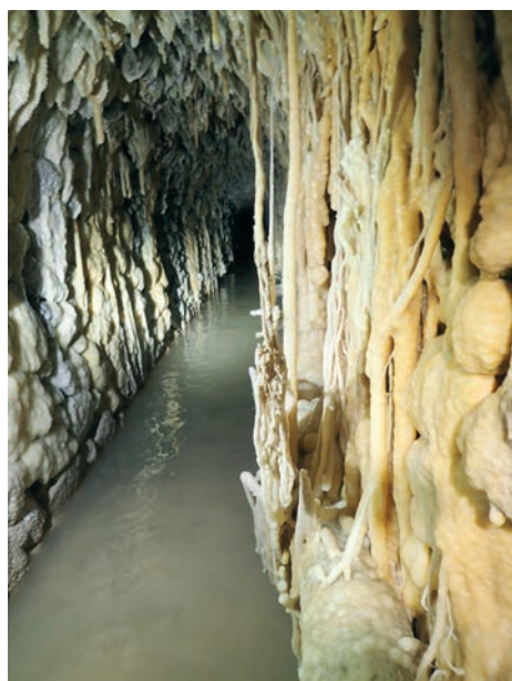
Concrétionnement de calcaire de végétation dans la galerie basse de la Bastide Cazeaux. Cliché ASSE
