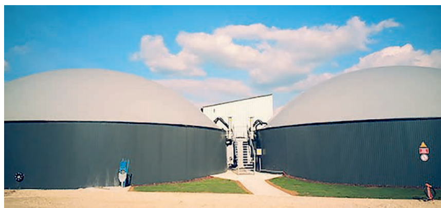
Digesteur et post-digesteur d'une unité de méthanisation.
