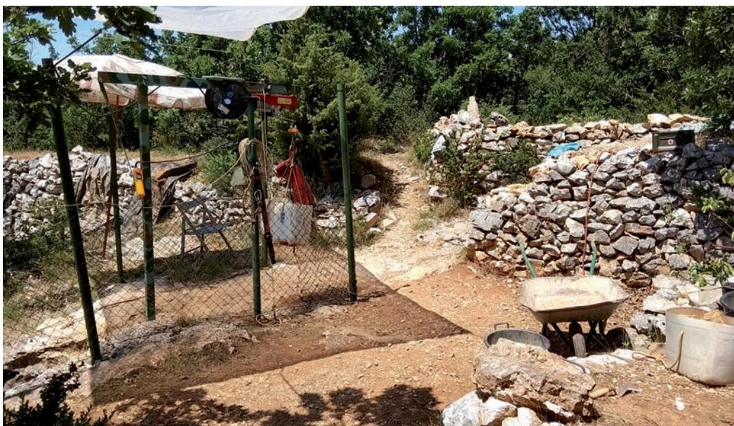
Protection de l'entrée, l'installation du treuil électrique ainsi qu'une vue sur les terrils réalisés avec les déblais du fond.
