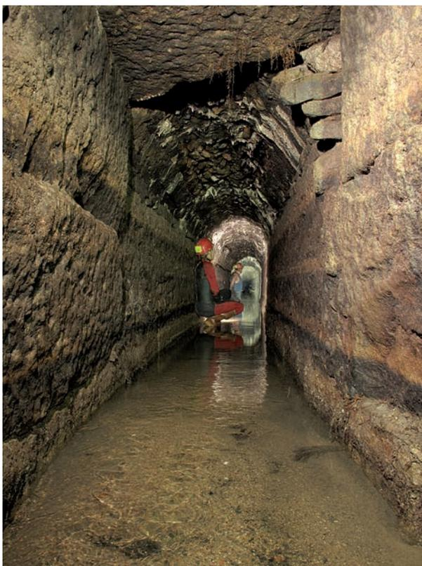
Photographie 3 : La partie aval du collecteur est en partie colmatée par des sédiments et en grande partie noyée. Cliché Ludovic Guillot.
