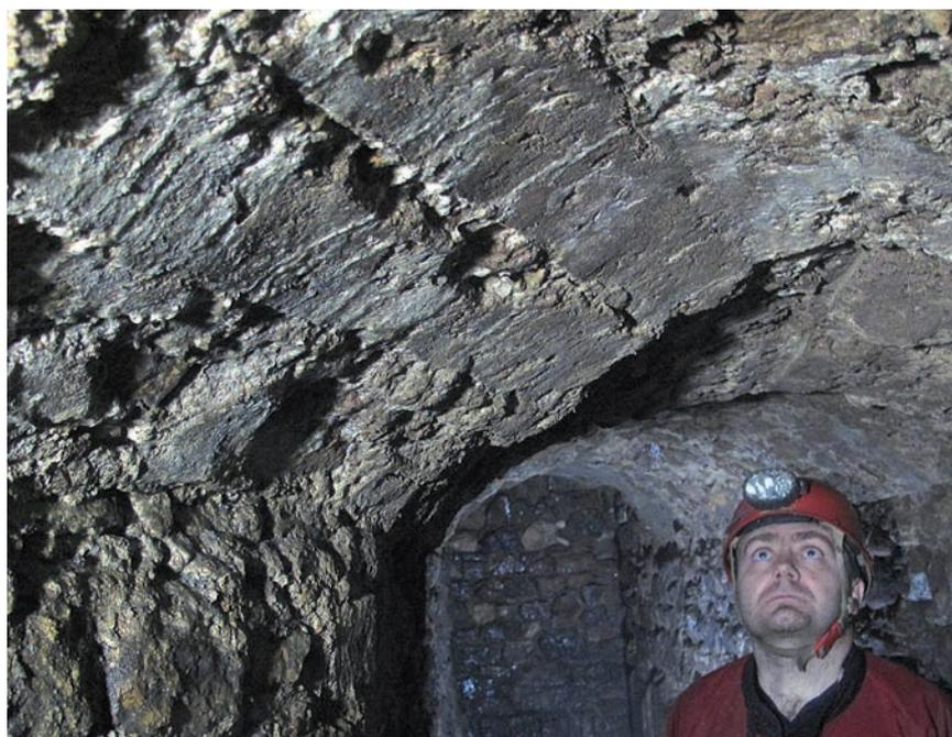
Photographie 7 : Vue de la voûte obtenue par coffrage. On distingue très nettement l'empreinte laissée par les planches ayant servi pour ce dernier. Cliché Ludovic Guillot.
