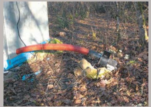
Sortie de la gaine d'évacuation du CO<sub>2</sub> avec la turbine d'aspiration complémentaire. Igue de Penayrols (82).
