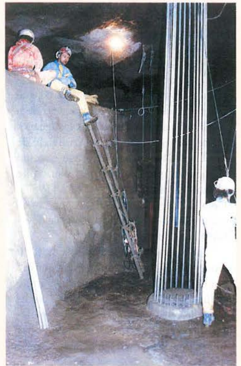
Équipe d'hydrokarst, 1987. Réalisation du forage de La Cha. Construction d'une retenue d'eau à 216 m de profondeur, dans le cours de la rivière, pour installer ensuite la pompe en site noyé.
