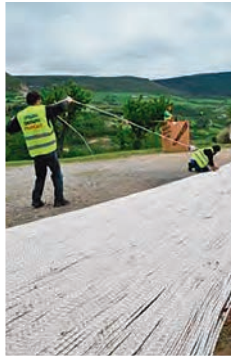
Vue sur le déploiement minutieux des 2870 m de corde au sol en préparation de la phase d'hélioportage.
