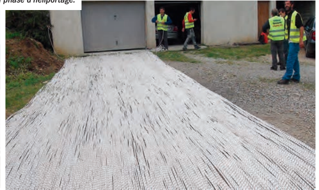
Vue sur le déploiement minutieux des 2870 m de corde au sol en préparation de la phase d'hélioportage.
