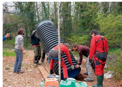
Photo 14 : Mise en place de la buse. Cliché Amandine Bertrand.
