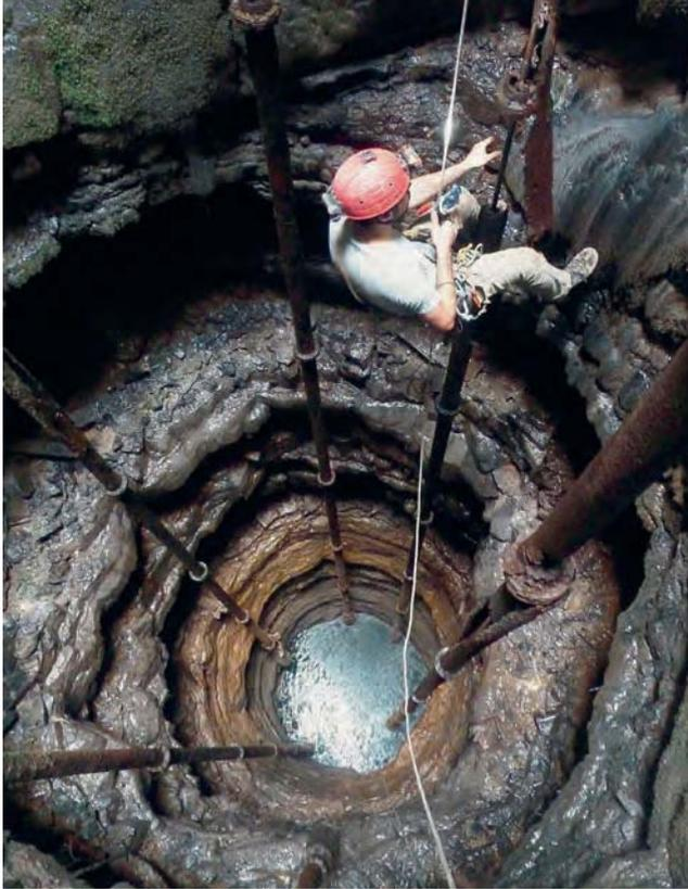
Le puits PU 211 est le plus profond : 28 m jusqu'à l'eau. Les pompes ont été abandonnées depuis longtemps, remplacées par un système d'arrosage venant d'énormes stations de pompage. C'est dans ce puits que débouche le qanât que nous avons pu visiter.
