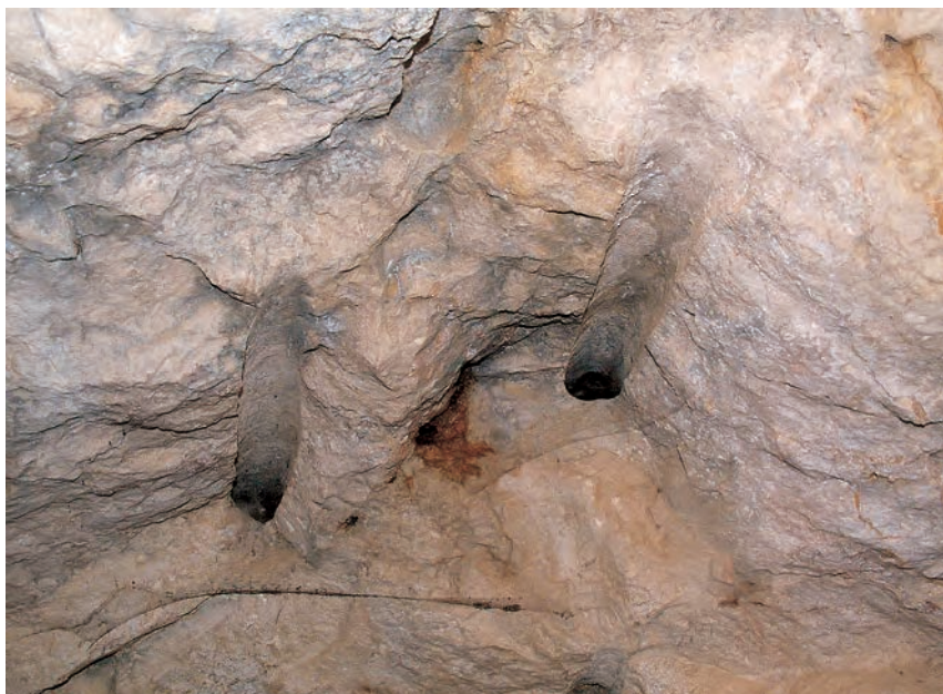
Les trous de barre à mine faits entre 1651 et 1653 marquent la première « dézob » à l'explosif !
