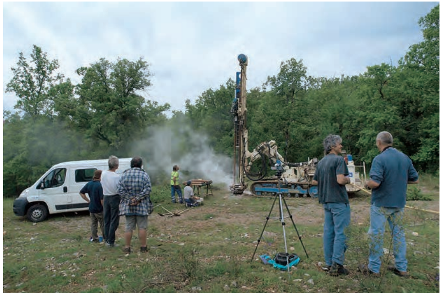
Site du Bret, début des travaux.
