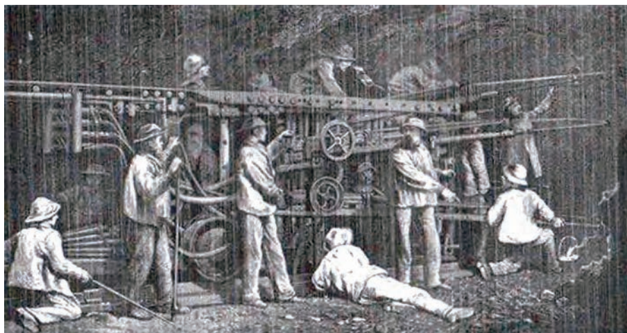
Première perforatrice employée au tunnel de Fréjus, d'après E. Wympet (1873).
