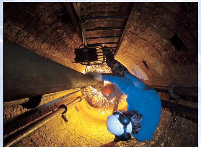
Les travaux de dépollution dans le puits. Cliché CDS 79.
