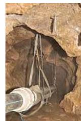
La première pompe de 2,30 m et 140 kg mise en place au barrage.
