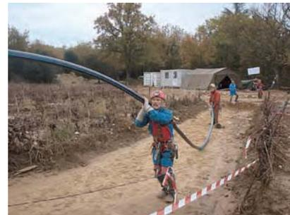
Transport du tuyau semi-rigide destiné à remonter les eaux pompées au barrage de -140 m.
