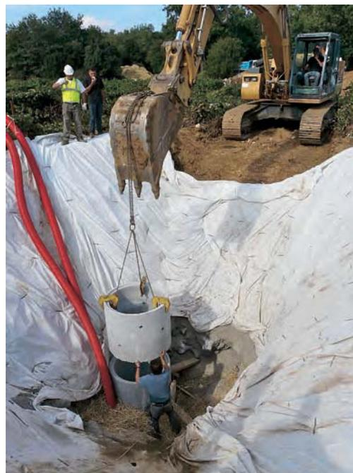
Mise en place de buses sur l'ouverture du puits de Ronze.
