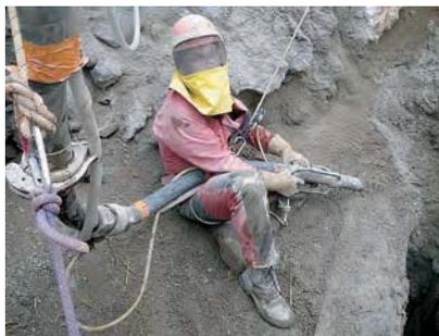
Stabilisation des parois par projection de béton.
