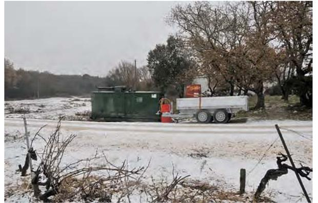
En capacité maximale, l'installation comportait jusqu'à cinq pompes débitant de l'ordre de 90 m<sup>3</sup>/h. Deux réseaux électriques l'alimentaient, l'un en 220 volts pour les pompes basse pression de type vide-cave, l'autre en 380 volts pour la grosse pompe haute pression du barrage.
