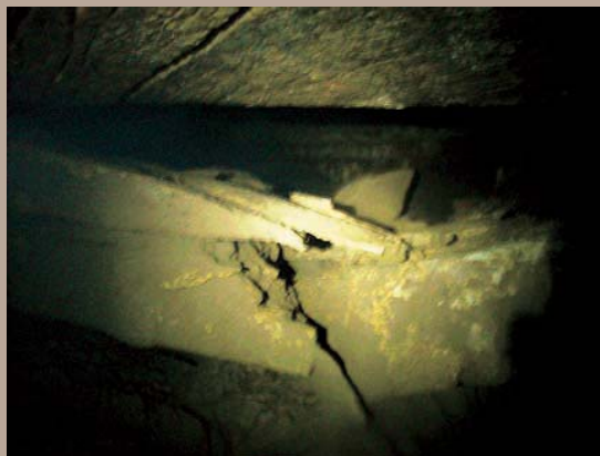
Effondrement de dalles entre S2 et S3.
