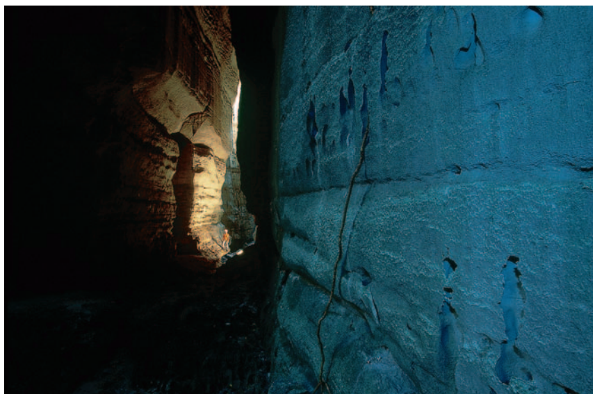
Encore quelques années et ce reste de galerie ne sera qu'un canyon de plus. Cliché DW.
